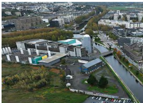
Emprise EDF à acquérir, hors poste source au droit de l'ESAM
