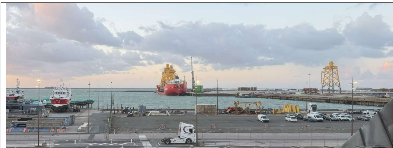
Derrière le bateau orange (transport de jackets, fondations métalliques d'éoliennes), la digue Hersand à démonter et reconstruire
