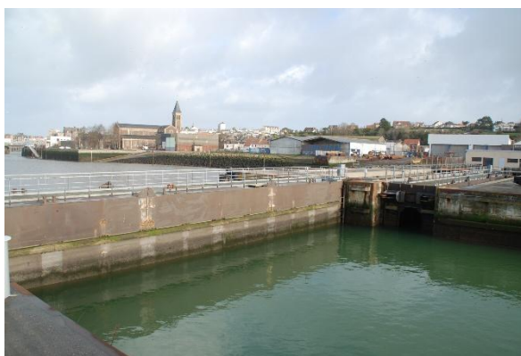
Portes de l'écluse Amiral Rolland– @Ports de Normandie
