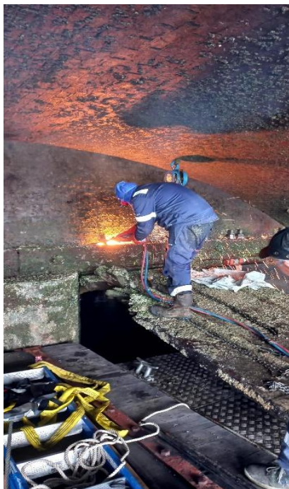
Photo 1 : travaux de soudure sur les clapets de l'Arques
