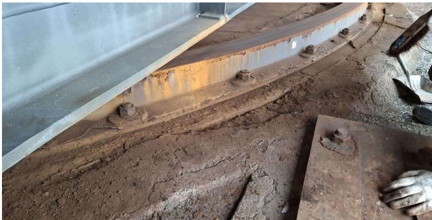
Détail du rail de roulement
