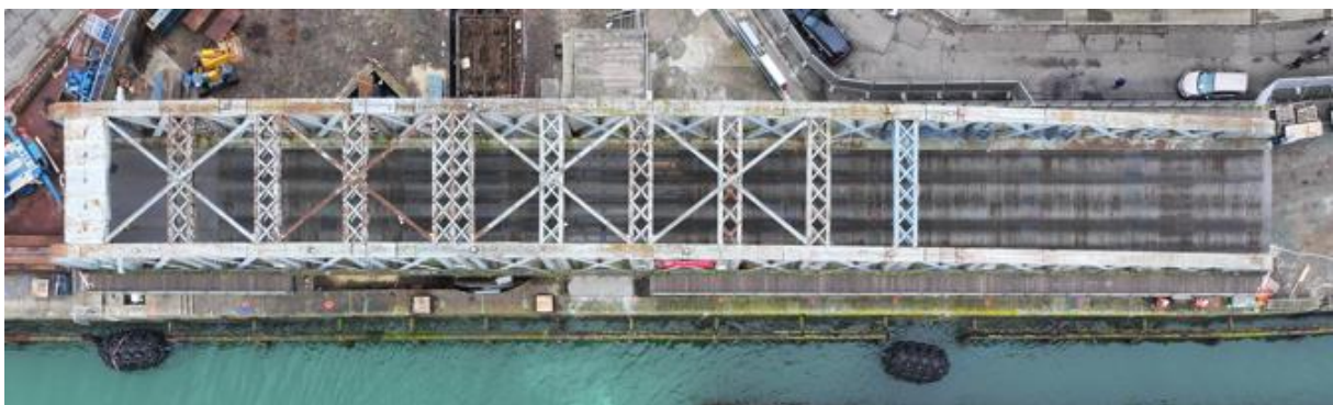
Les entretoises sont les « poutres transversales en croisillons » que l'on aperçoit sur la photo ci-dessus ©Drones Smart Images
