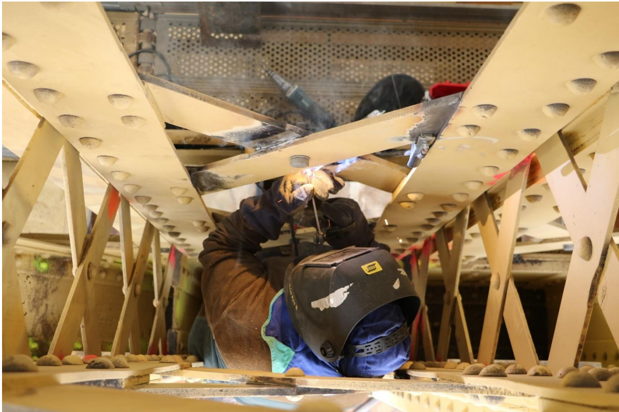
Les travaux sur la structure du Pont Colbert ©F. Thomas - Ports de Normandie
