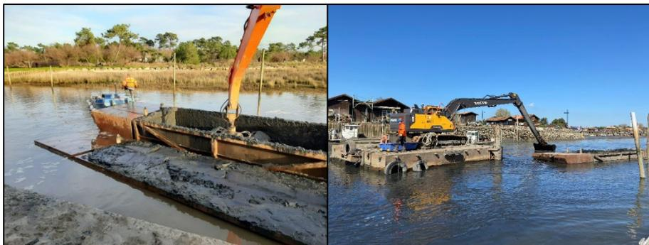
Dragage : Extraction par dipper et transport par barge
