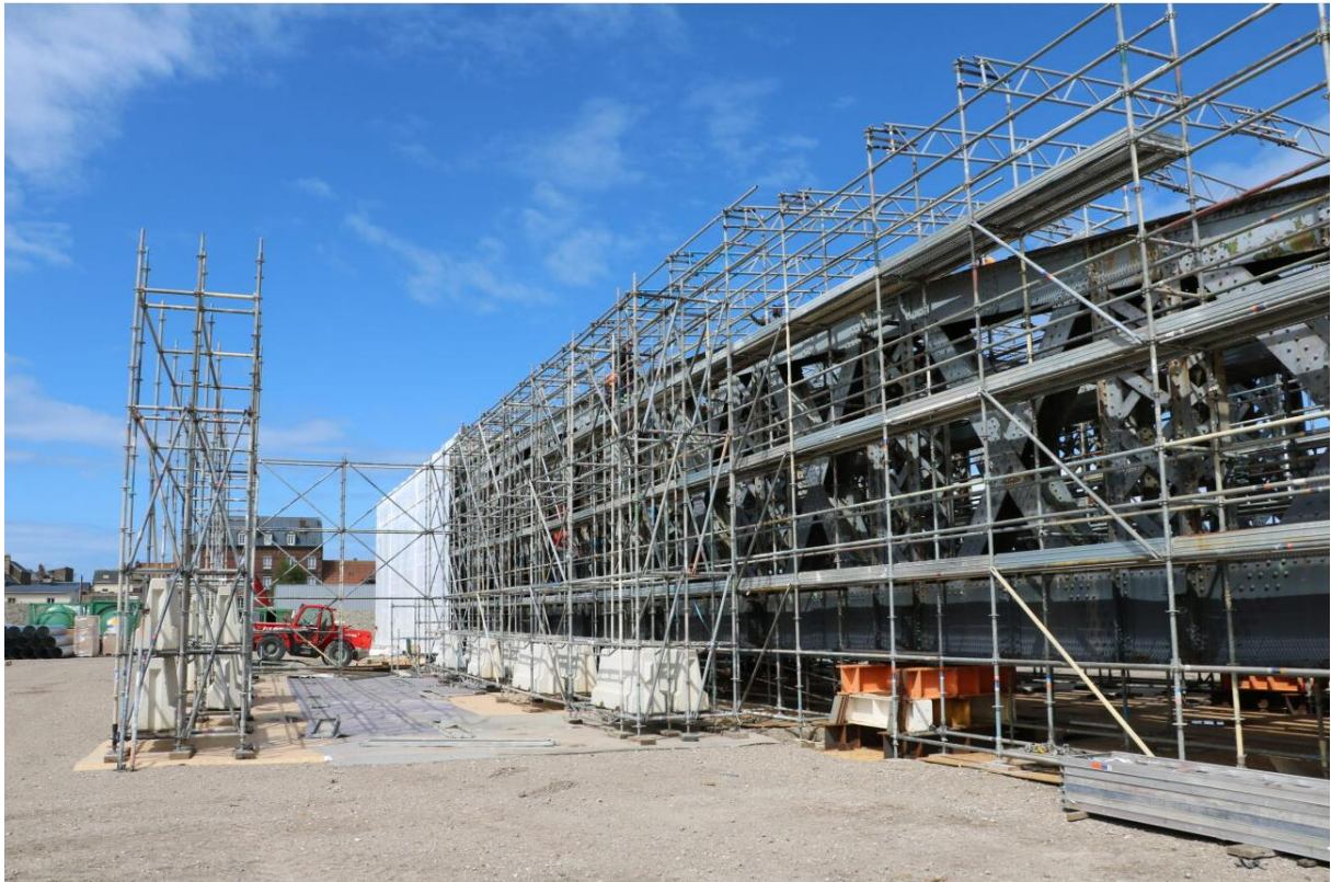
Le Pont Colbert entouré de son échafaudage et d'une partie du cocon ©F. Thomas – Ports de Normandie
