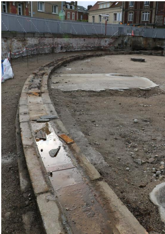
Les pierres sur lesquelles reposent les rails de rotation du pont ©F. Thomas – Ports de Normandie
