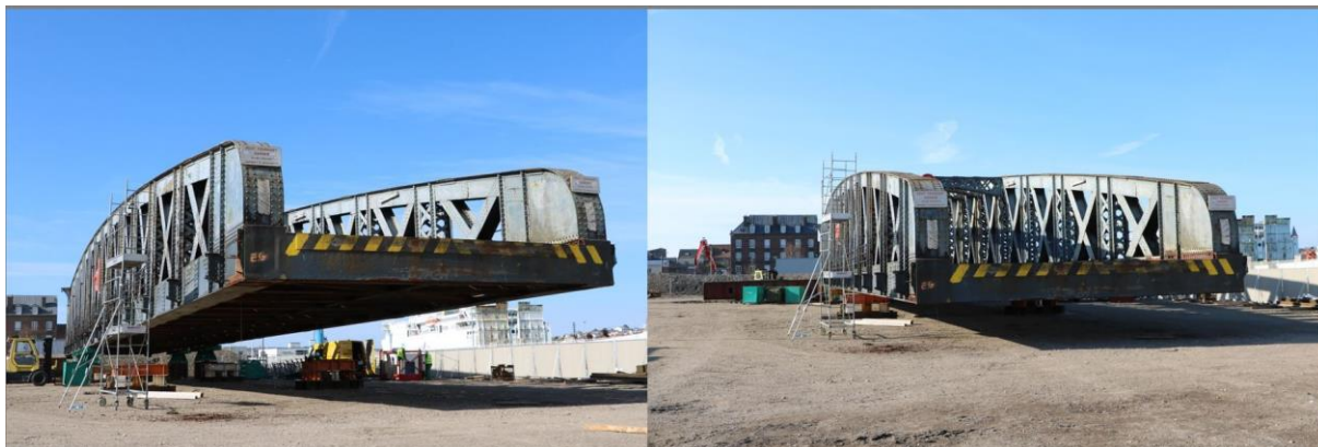
Dévérinage du Pont Colbert avant/après ©F. Thomas – Ports de Normandie
