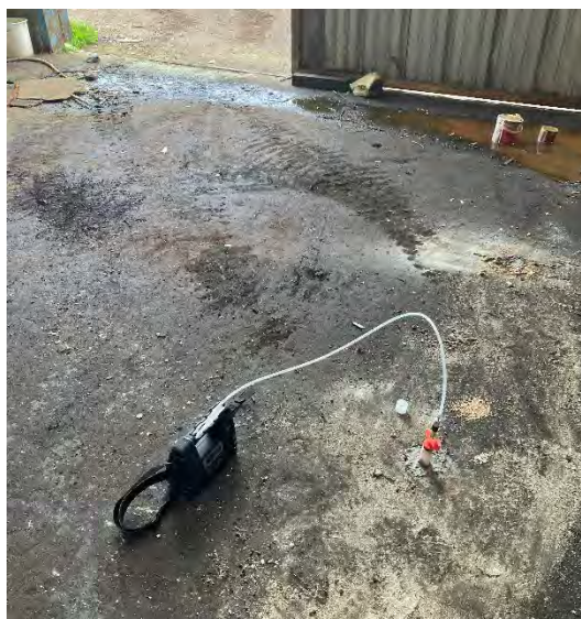
Figure 12 : Photographie réalisée lors de la pose du piézairs W7-Pza
