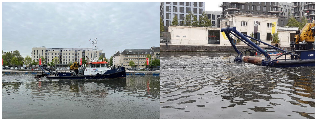
Nivelage réalisé en 2022 - ©PortsdeNormandie
