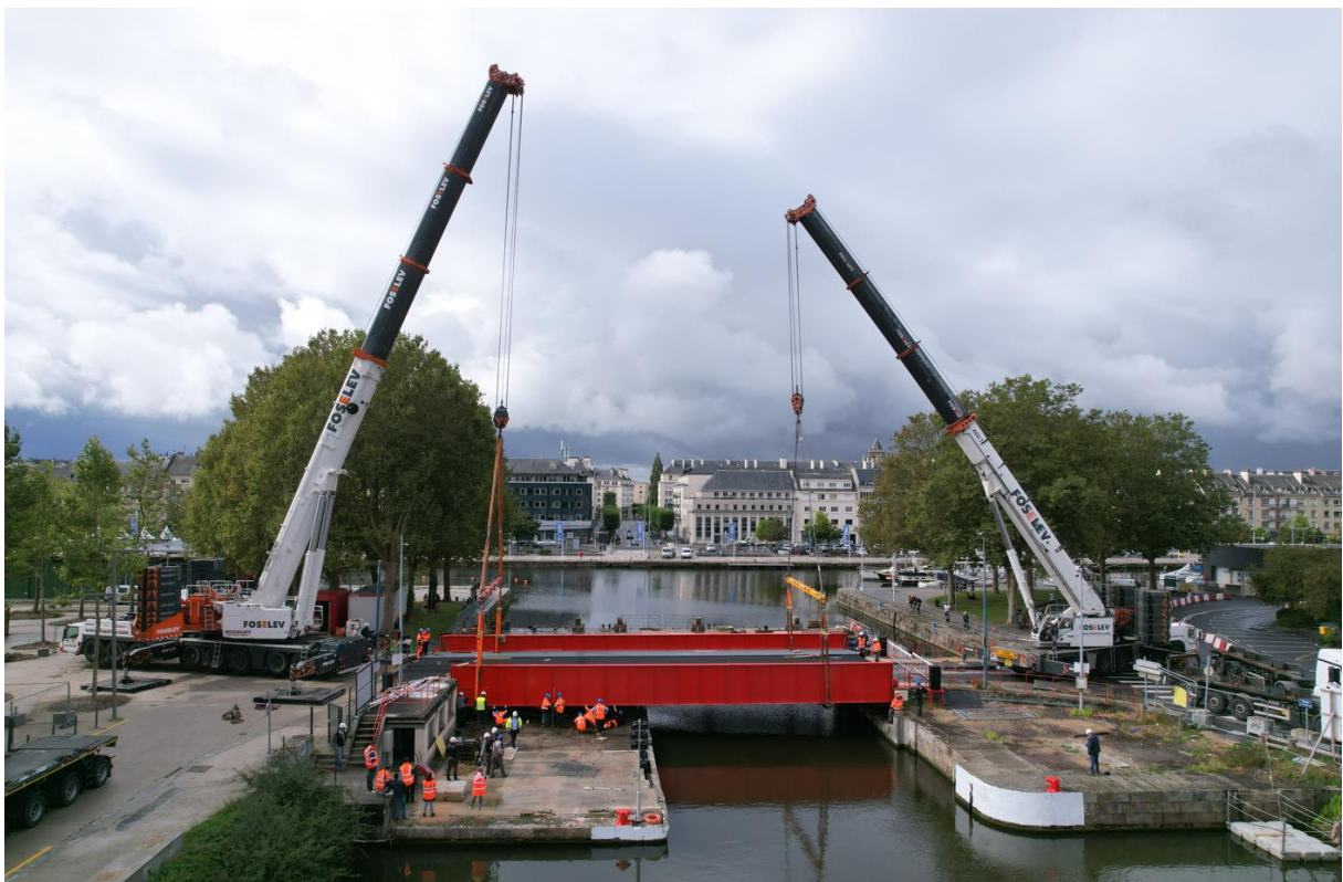
La repose du pont de la Fonderie sur ses appuis ©Eric Destable pour Ports de Normandie
