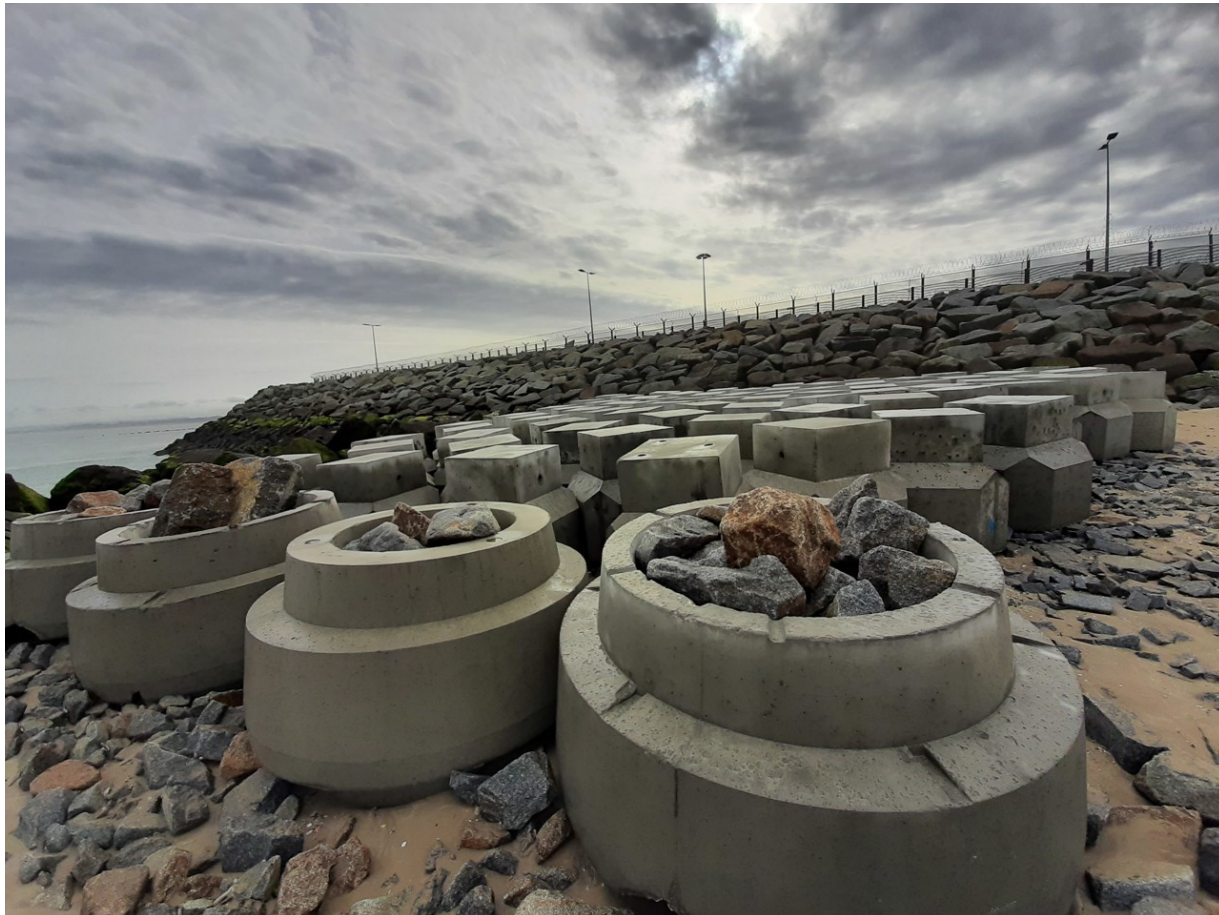
D »un nouveau type, les blocs ronds ACCROBERM™ sont testés sur les côtes de la Manche. (©Arnaud Hérault/Liberté Le bonhomme Libre)
