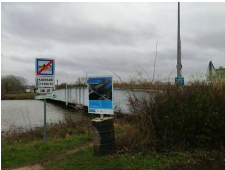
Panneaux sur la voie verte rn rive gauche du pont
