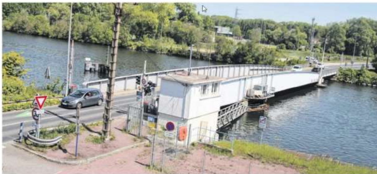
Les habitants du secteur et les utilisateurs du pont de Colombelles sont invités à donner leur avis à partir du lundi 1 er février : le futur pont de Colombelles sera construit à une quarantaine de mètres à l'aval de l'existant. Les travaux auront lieu entre le printemps 2022 et l'été 2023.
