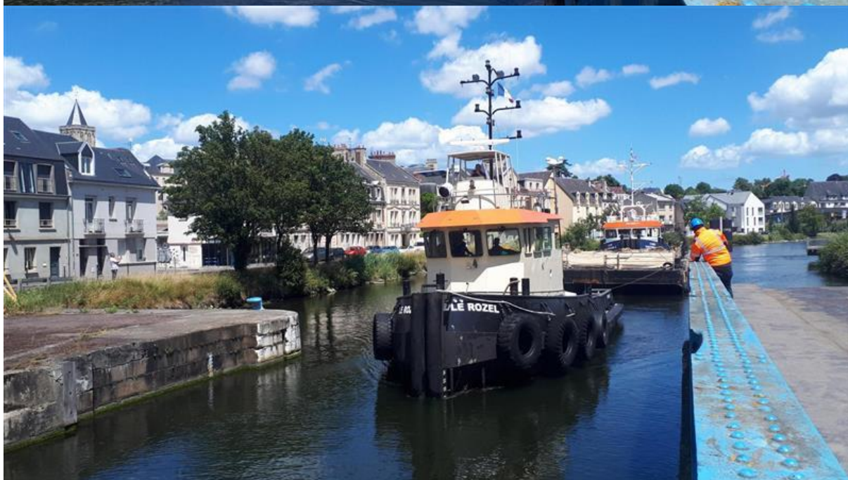
Arrivée, à proximité du Pont de la Fonderie, de la barge qui le transportera jusqu'au quai Gaston Lamy ©Ports de Normandie
